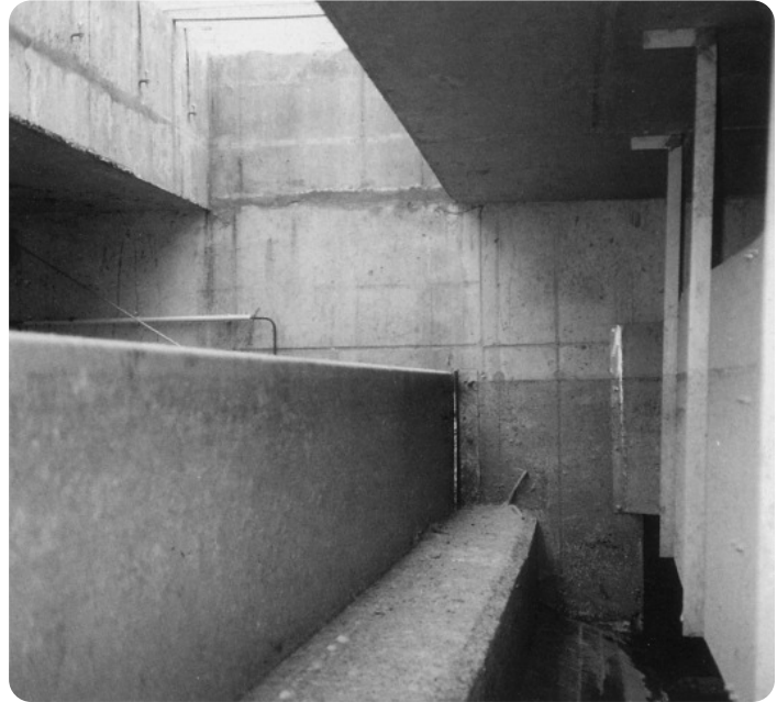
Ein Stauschild für konstante Wasserspiegellagen in Regenbecken und Kläranlagen.
